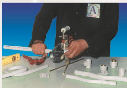
جوش لوله و اتصال بر مبنای حرارت ۲۴۰ درجه
