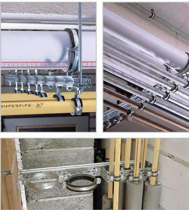
بستها برای نصب انواع لوله‌های فلزی، پلیمری و کامپوزیتی برای سیستم‌های آبرسانی، سرمایشی و فاضلاب کاربرد دارند و نقش مهمی در حفظ و نگهداری شبکه لوله‌های تاسیساتی در محل استقرار، ایفا می‌کنند.
